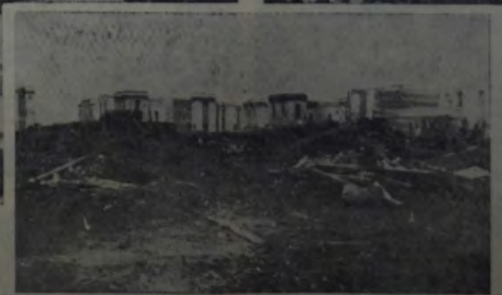
EN EL CENTRO DEL BARRIO DE CASAS ECONOMICAS DE LINIERS Tuyuti y Cosquin, la Compañía de construcciones modernas dejó un gran espacio sin edificar. Se dijo que se destinaba a plaza pública. Pero, hasta ahora es un depósito de materiales y de basuras. (Hasta cuándo el departamento ejecutivo tolerará ese abuso de la Compañía de construcciones modernas?)
