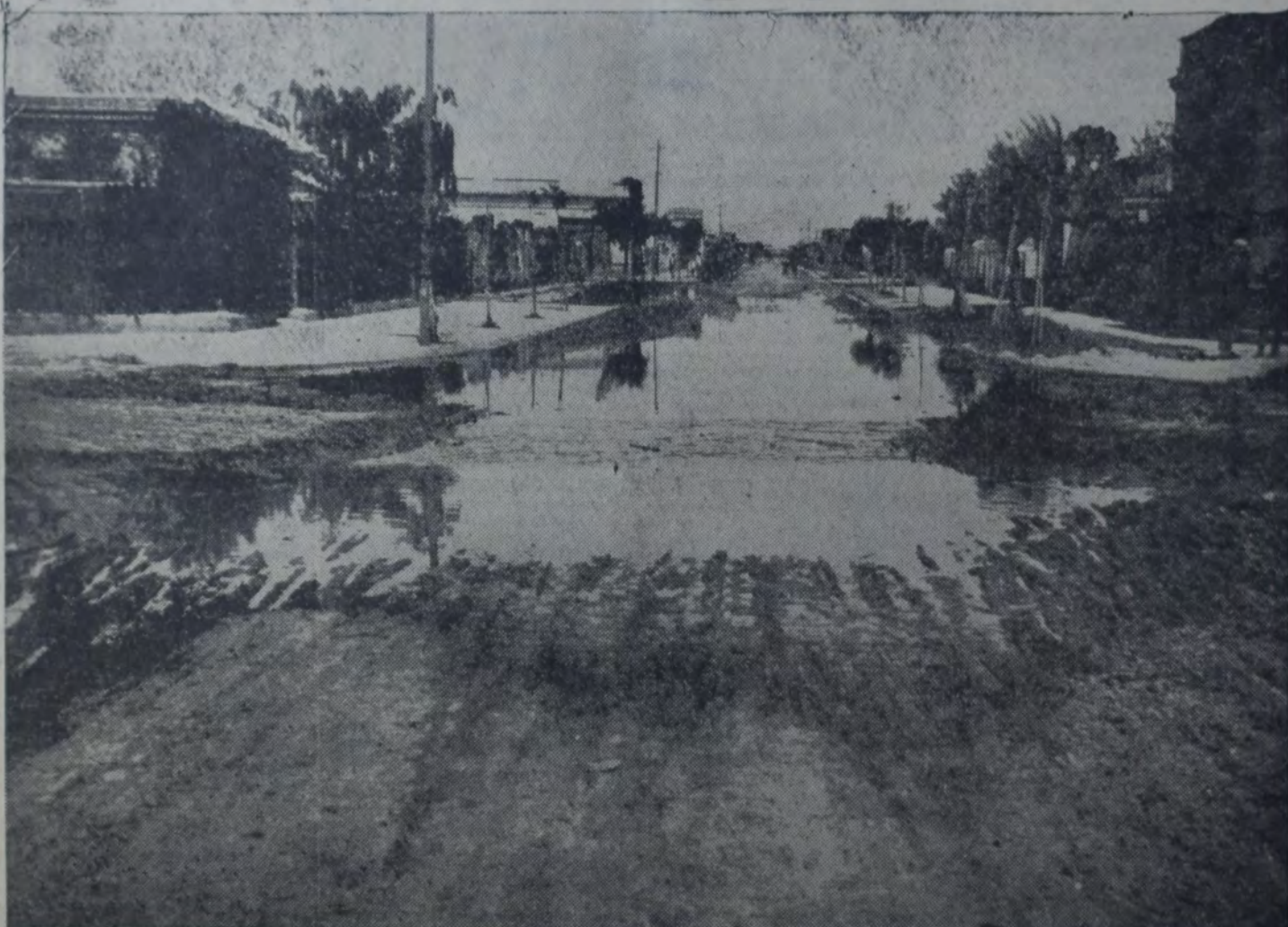
ESTA FOTOGRAFIA NO FUE TOMADA EN DIA DE LLUVIA, NI SIGUIENTE A UNO DE LLUVIA. FUE TOMADA EN DIA DE SOL Y CUANDO HACIA ya tiempo que no había llovido. El cruce de Caaguazú y Oñden, es un pantano permanente, formado por las aguas servidas sin salida. El fenómeno se debe a la forma increíble en que se pavimentó la calle Oñden. Se pavimentó el cruce a bajo nivel, formando un pozo. La inspección técnica municipal, como de costumbre, dejó hacer. No en balde se habla tan a menudo de negocios raros que benefician a las empresas de pavimentación muy vinculadas a la intendencia. Conviene decir que en toda esta parte de Liniers las casas han sido construidas a bajo nivel, aunque los niveles... eran municipales!
